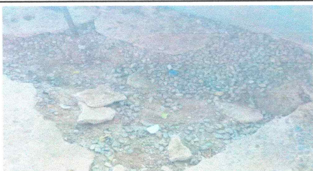
Foto 3: Reparacion de piso
