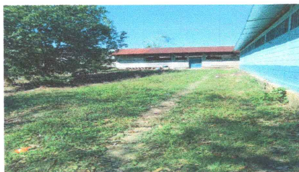
Foto 4: Cambio de techo de cocina
