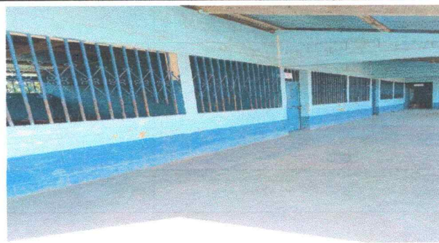
Foto 2: Cambio de balcones
